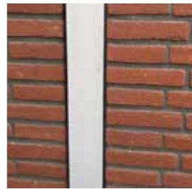
Hemelwaterafvoer in metselwerk
