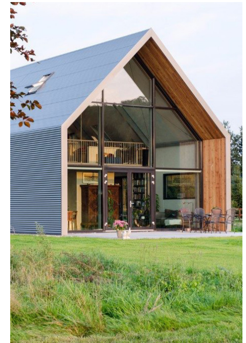
Special - Door het verlengen van het casco ontstaat een veranda die zich oriënteert op het groen hof.
