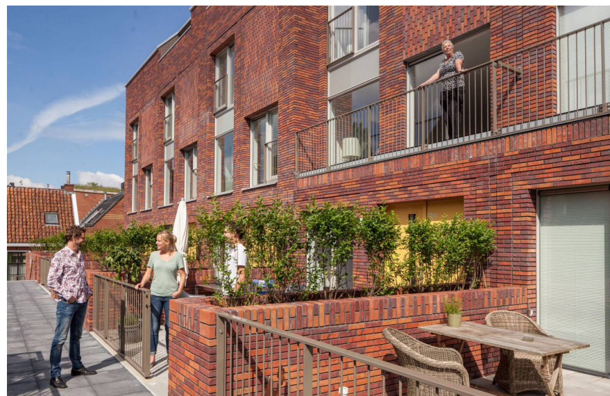
Balkons, dakterrassen en loggia's zorgen voor een levendige wand aan Park Meerstad - Agaathhof, Groningen.
